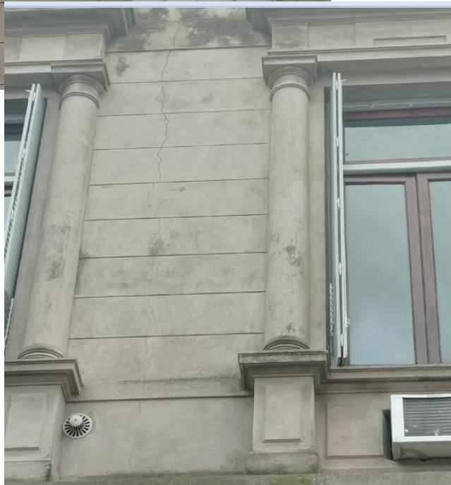
Fisuras sobre FRENTE calle Rocamora
